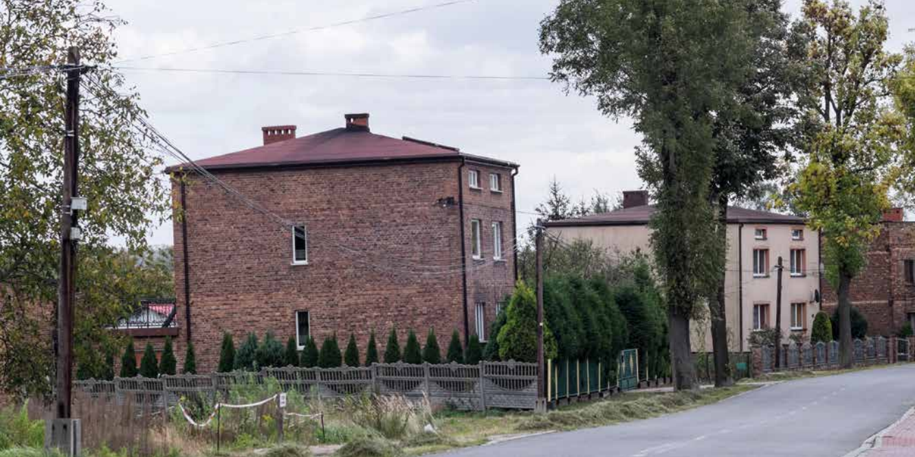
Poškozené domy nad ložiskem 4 Imielin Jih.
