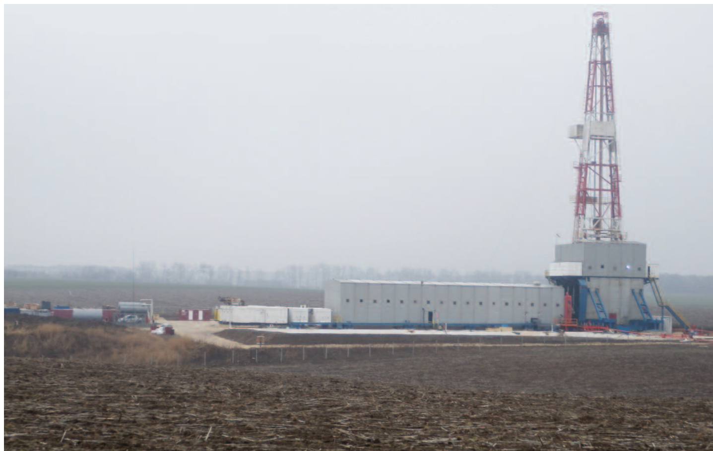
Vrtná plošina v Bulharsku. Každá plošina potřebuje plochu až 4 hektarů pro umístění všeho vybavení pro frakování.
